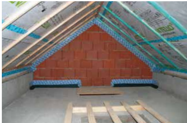
Luchtdichte folies bij een hellend dak, vóór het aanbrengen van de binnenbepleistering.
